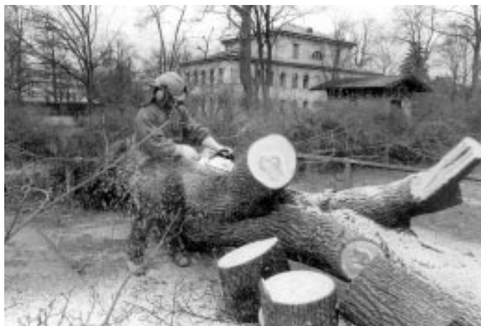
Auf dem Klinik Nordgelände wurde gerodet, damit die Vorbereitungen für den ersten Spatenstich zum Bau des Nichtoperativen Zentrums am 23. Juni durch Ministerpräsident Edmund Stoiber erfolgen können. Foto: Böhner
