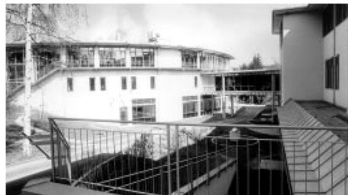
Eine Brücke verbindet den Küchenbereich (rechts) mit dem halbrunden Bau des Speisesaales (links). Der Saal kann, so eines Vision des Ärztlichen Direktors Prof. Sauer, auch für Kongresse, Tagungen und verschiedene Veranstaltungen genutzt werden. Foto: Sippel
