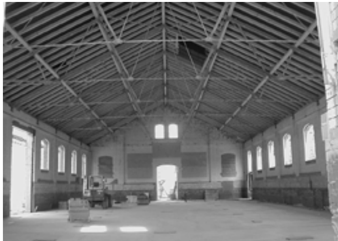
In die ehemalige Reithalle wird eine 33,5 Meter lange Kranbahn mit 5 Tonnen Nutzlast eingebaut. Foto: UBA
