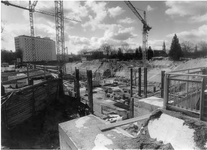
Erlangens größte und teuerste Baugrube befindet sich zur Zeit auf dem Nordgelände des Universitäts-Klinikums am Maximiliansplatz: Hier entsteht für 192 Millionen Mark bis zum Jahr 2001 das Nichtoperative Zentrum. Bei seinem Besuch im März konnte sich Ministerpräsident Dr. Edmund Stoiber davon
