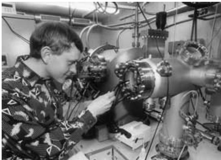
Dr. Grill an der „Molekularstrahlepitaxie-Anlage“ des Lehrstuhls für Halbleiterphysik. Mit dieser Anlage werden die nur wenige Millionstel Millimeter dicken dotierten Halbleiterschichten hergestellt, deren Eigenschaften Herr Grill theoretisch berechnet. Foto: Sippel
